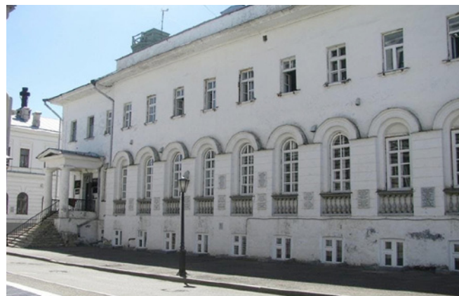
Здание “старого” Бутлеровского института (2018 г.).
